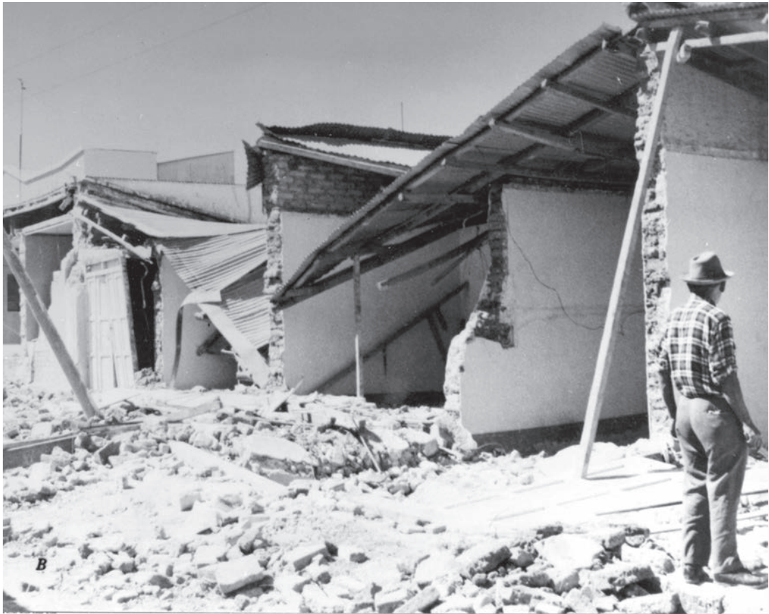
Daños causados por el terremoto de 1976 en Guatemala
