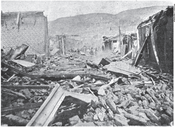
Daños provocados por los sismos
